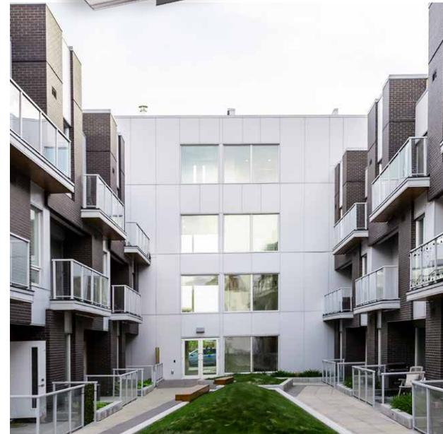
Les systèmes QuickPanel<sup>®</sup> sont composés de panneaux ACM polyvalents qui redéfinissent l'esthétique des bâtiments et les normes de performance. QuickPanel<sup>®</sup> se distingue par ses innovations brevetées, notamment un écran pare-pluie intégré à pression équilibrée, garantissant un drainage, une circulation de l'air et une ventilation exceptionnels.
